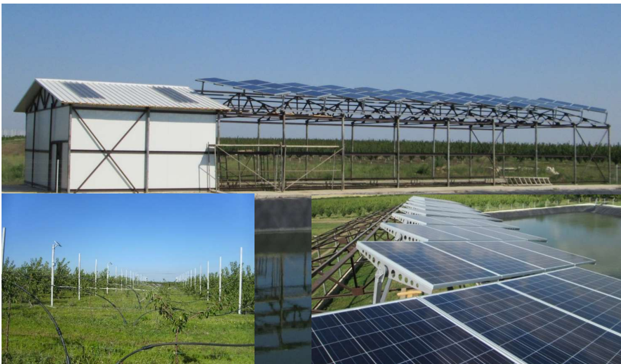
Fig. 3. Panouri fotovoltaice integrate în sistemul de irigare a unei livezi de cireși (gospodăria agricolă Tridenal SRL, or. Criuleni).
